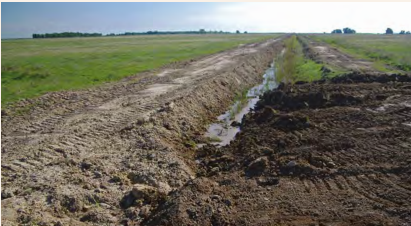
42. és 43. fénykép. Hajdani öntöző- és rizsrendszerek csatornáinak betemetése dózerek segítségével Angyalfázán (KOVÁCS GÁBOR). Photos 42 and 43. Filling up of the channels of the former irrigation systems and paddyfields with bulldozers in Angyalfázán
