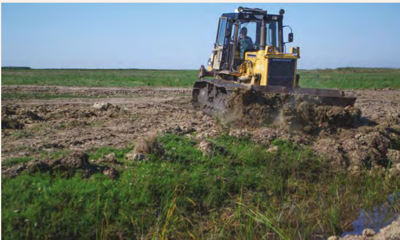
42. és 43. fénykép. Hajdani öntöző- és rizsrendszerek csatornáinak betemetése dózerek segítségével Angyalfázán (KOVÁCS GÁBOR). Photos 42 and 43. Filling up of the channels of the former irrigation systems and paddyfields with bulldozers in Angyalfázán
