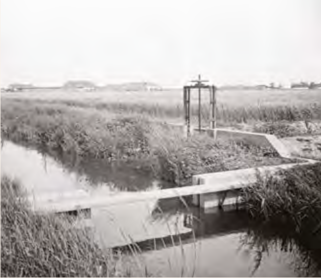
25. fénykép. A szikesek elleni küzdelem egyik utolsó lépése a terület felparcellázása és hasznosítása, pl. rizstelepekként (Déri Múzeum Fotótár). Photo 25. One of the final steps in the fight against sodic habitats was the parcelling and utilization of the area as paddy fields (Photo gallery of Déri Museum)
