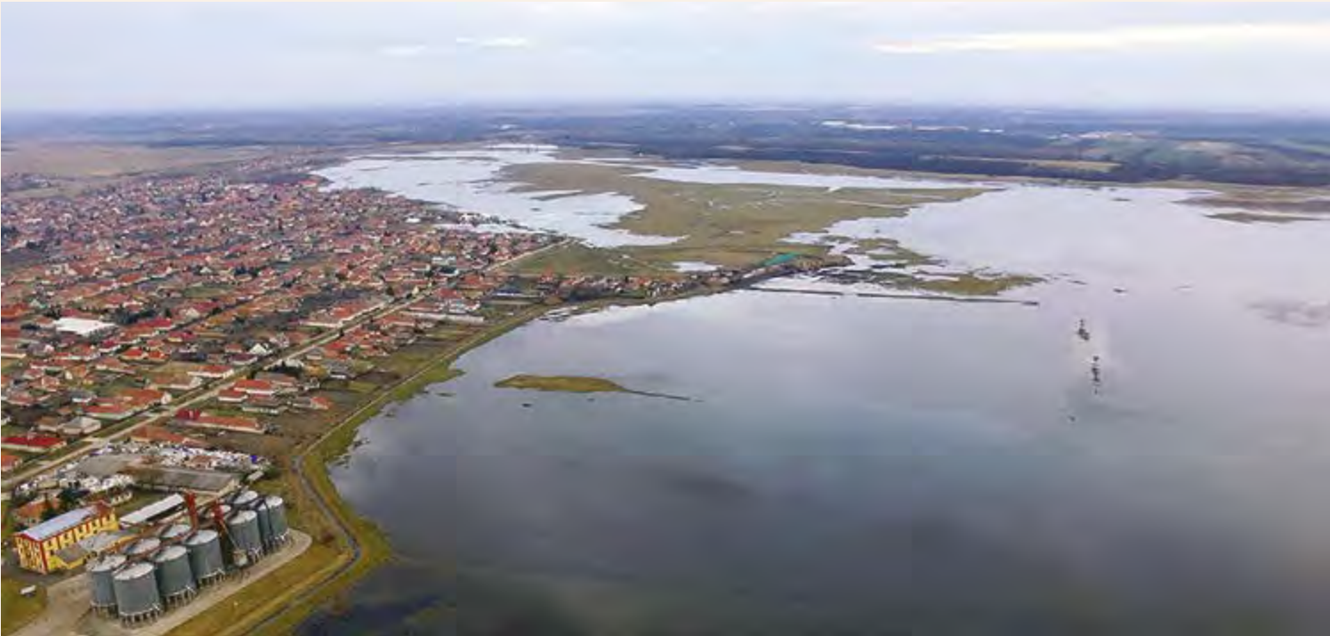
26. fénykép. A balmazújvárosi Nagy-sziken egy övcsatorna és egy töltés megakadályozza, hogy szennyezett csapadékvíz érkezzon a védett területre a település irányából (SZILÁGYI ATTILA). Photo 26. On the Nagy-szik in Balmazújváros, a diversion ditch and an embankment prevent contaminated rainwater from entering the protected area.
